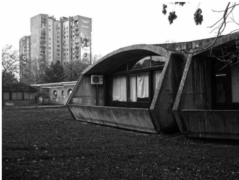
Slika 5. VVZ »Slavuj« v novobeograjskem stavbnem otoku 28 Foto: avtor prispevka, november 2014
